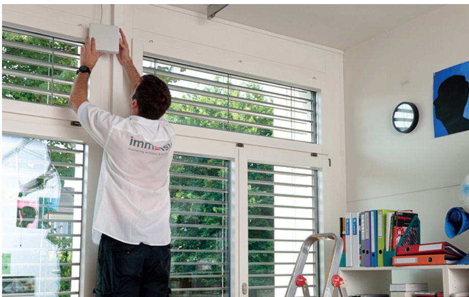
Installation Wi-Fi im Klassenzimmer.
